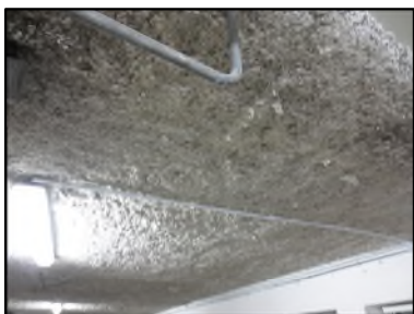
Photo N° 585 ECH-N°1 FLOCAGE -- Parking Plafonds Blanc cotonneux
